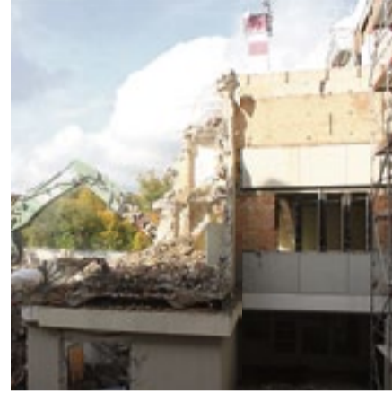
Ende Oktober standen nur noch wenige Fragmente des einst vierstöckigen Erweiterungsbaus mit Teilunterkellerung.
