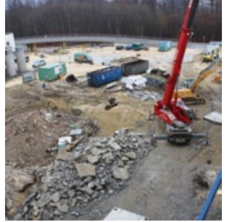
Ende November waren noch die Kellerwände zu sehen, ebenso war die alte Cafeteria verschwunden und am Funktionsbau wurden große Betonfassadenelemente entfernt.
