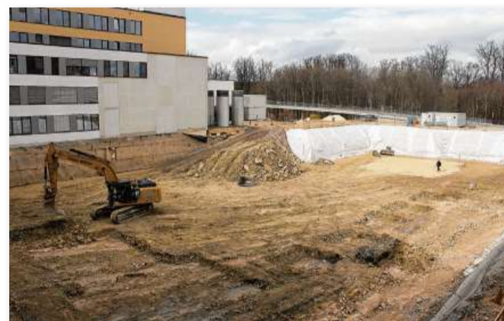
Im März 2018 sind die Arbeiten für die Gründung mit der Einmessung des Schnurgerüsts angelaufen.
